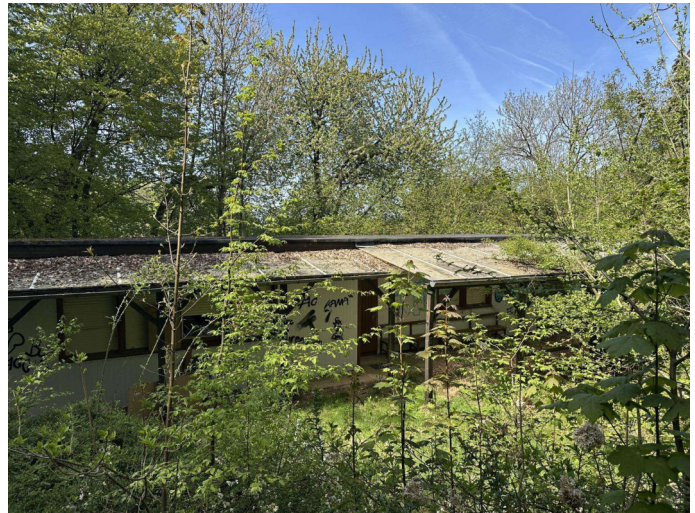
ehemaliges Freizeitheim, Blick Richtung Westen
