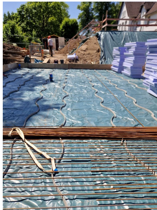
Untere Bewehrungslage mit Abstandhaltern
