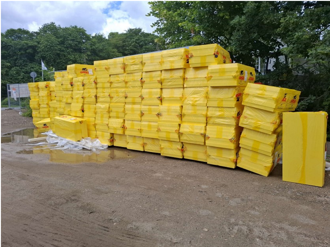
Dämmung für die erdberührten Außenwände
