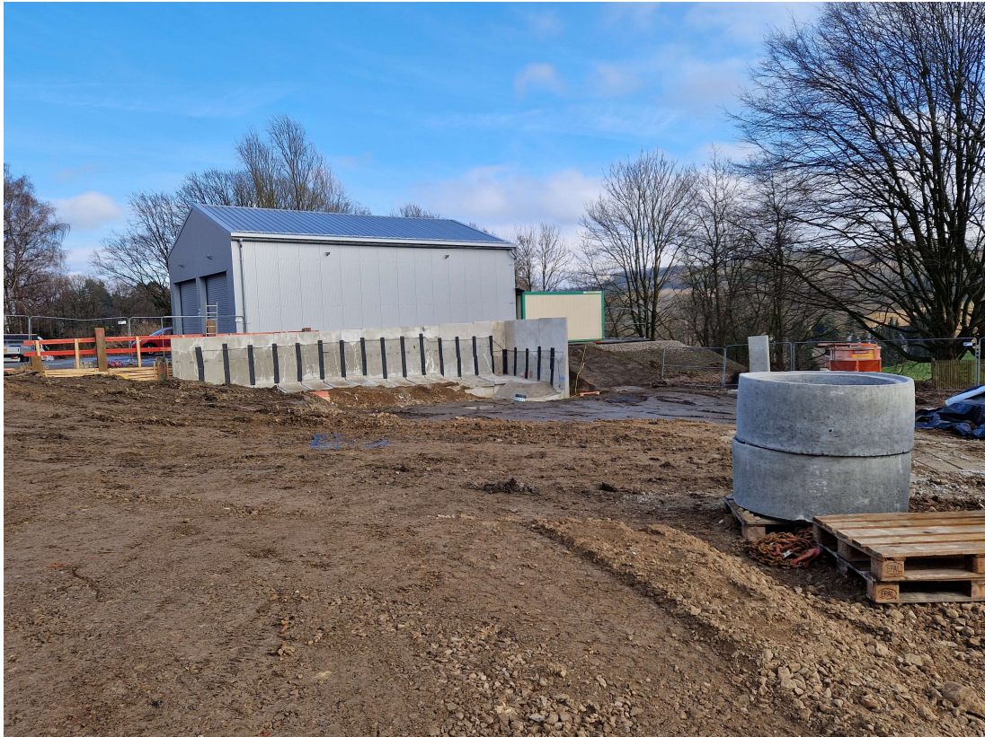
Stützwände am östlichen Grundstücksgrenze. Die Oberkante entspricht dem späteren Geländeniveau der Hoffläche
