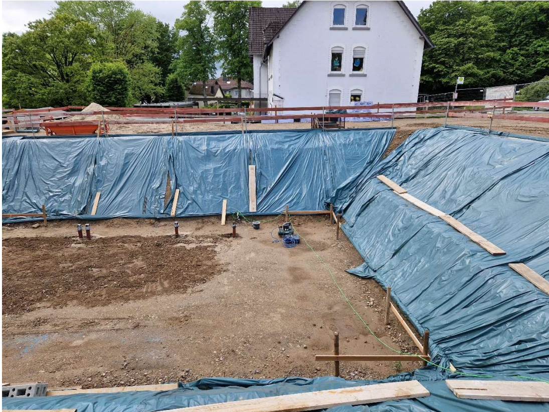
Baugrube nach Einbau der Grundleitungen und Verfüllung
