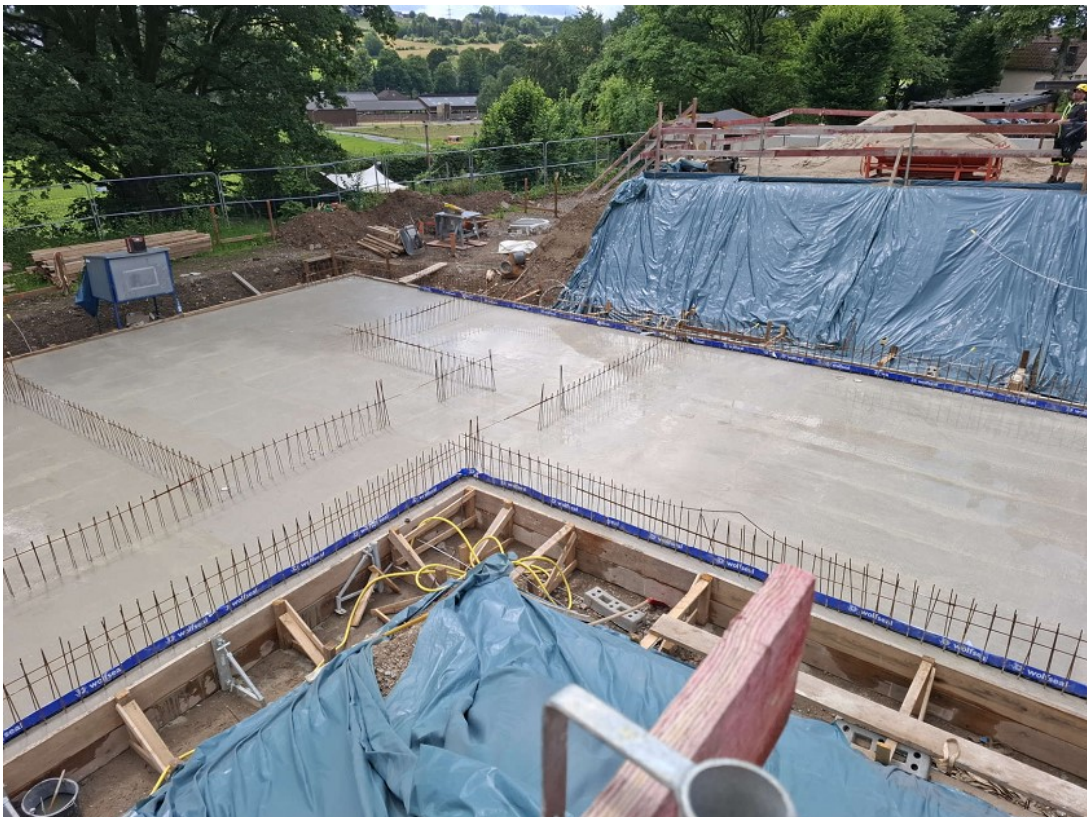
Betonierte Bodenplatte mit Anschlusseisen für die aufgehenden Wände – die späteren Räume sind ablesbar
