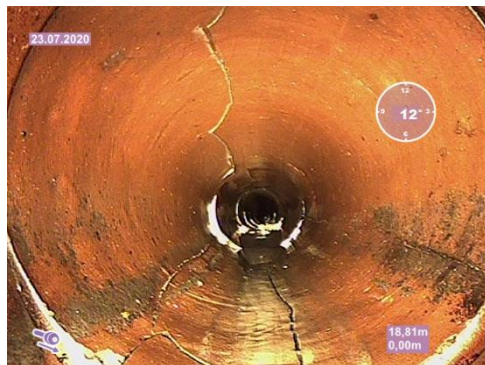
TV-Untersuchung schadhafter Kanalhaltungen Wurzeleinwuchs bzw. Rissbildung
