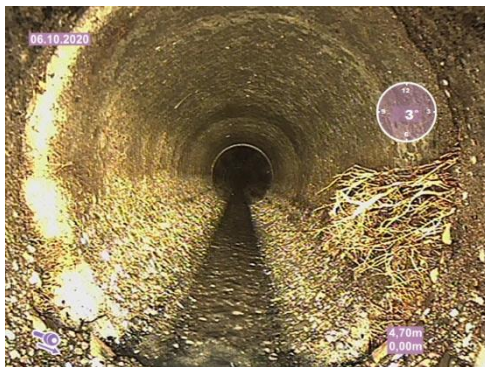
TV-Untersuchung schadhafter Kanalhaltungen Wurzeleinwuchs bzw. Rissbildung
