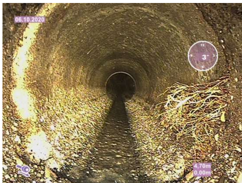
TV-Untersuchung schadhafter Kanalhaltungen Wurzeleinwuchs bzw. Rissbildung
