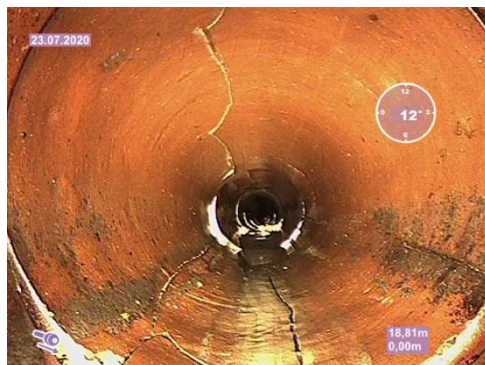
TV-Untersuchung schadhafter Kanalhaltungen Wurzeleinwuchs bzw. Rissbildung
