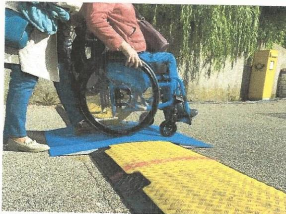
Kabelbrücken sind oft sehr hoch und bilden so eine Barriere und Gefahrenstelle für Menschen im Rollstuhl oder Menschen mit Rollator. Mit solchen Abflachungen können diese Barrieren und Gefahrenstellen verhindert werden.
