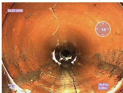
TV-Untersuchung schadhafter Kanalhaltungen Wurzeleinwuchs bzw. Rissbildung
