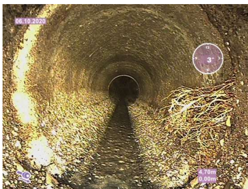
TV-Untersuchung schadhafter Kanalhaltungen Wurzeleinwuchs bzw. Rissbildung
