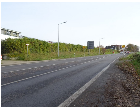
Am Nordrand des Plangebiets verlaufende Winterberger Straße (B 483) mit angrenzendem Wohngebiet hinter einer begrüntem Lärmschutzwand
