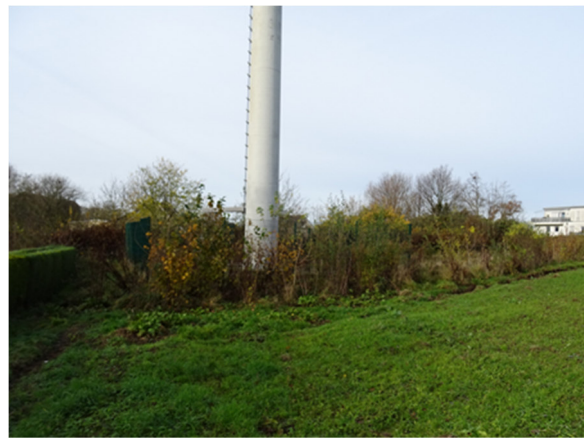
Blick auf den Funkturn (südwestlich des Plangebiets) mit Strauchpflanzung innerhalb der Einzäunung
