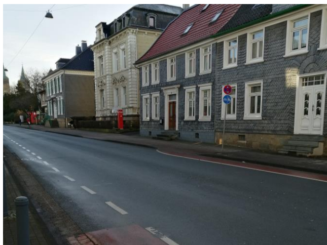
Bild 14: Überleitung Schutzstreifen auf getrennten Geh- und Radweg auf Hauptstraße (Nähe heutiges Rathaus) in Fahrtrichtung Innenstadt
