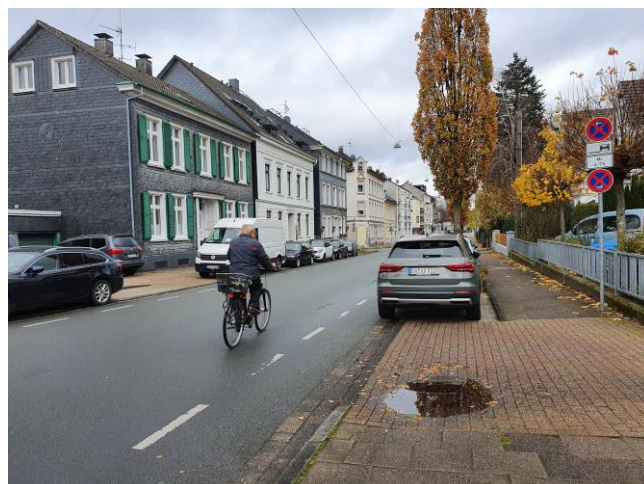
Bild 15: Schutzstreifen neben Parkbuchten auf Hauptstraße Fahrtrichtung Möllenkotten
