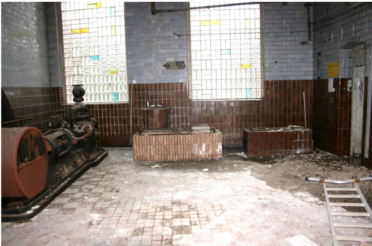
Abb.5. Maschinenhaus mit Dampfmaschine im Innenraum. Glasbausteine ersetzen die Fenster. Foto: Dahms 9.03.23.
