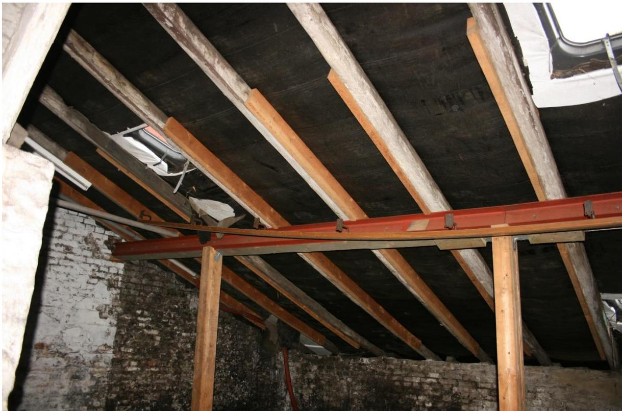
Abb. 10. Abgefangene und verstärkte Dachkonstruktion im Gebäude. Foto: Dahms 9.03.23.
