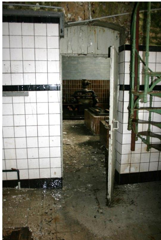
Risse, Schutt von der Decke und Wasserpfützen in Kessel- und Maschinenhaus sowie der Schlosserei. Fotos: Dahms 9.03.23.
