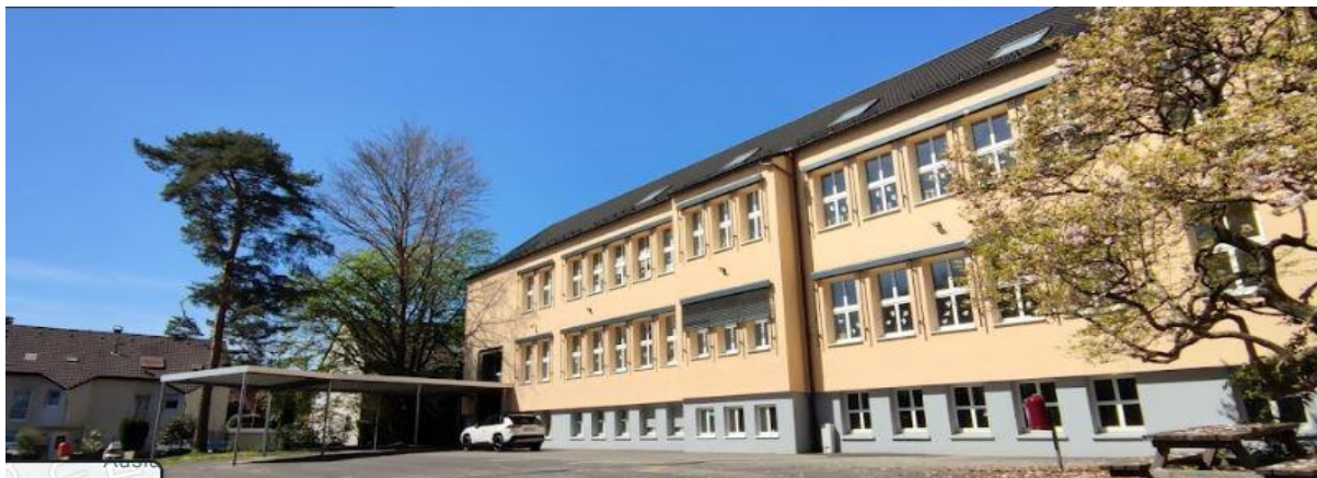
Grundschule Nordstadt Schwelm, Hattinger Str. 47, 58332 Schwelm
