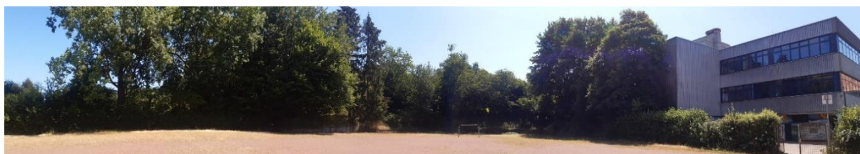
Der Sportplatz und das Treppenhaus des „Neubaus“
