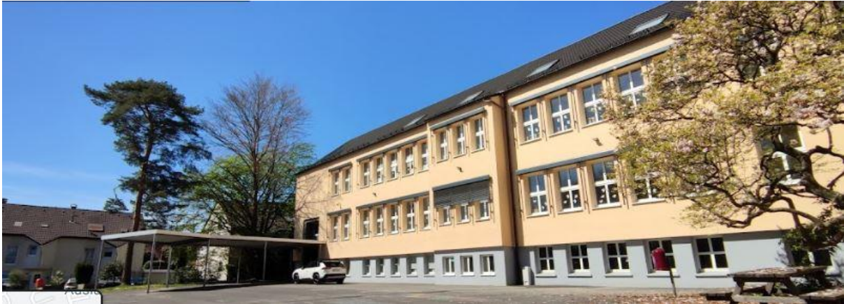
Grundschule Nordstadt Schwelm, Hattinger Str. 47, 58332 Schwelm
