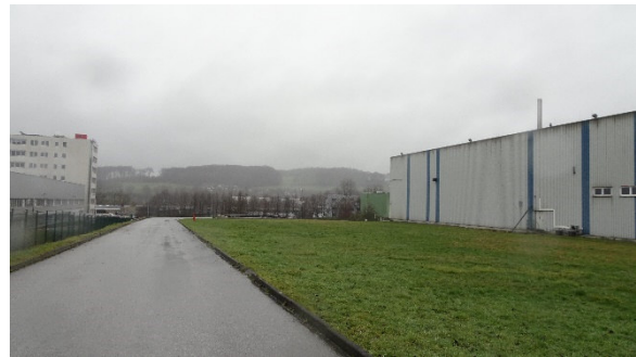
Strukturarme Rasenflächen und Gewerbehallen am westlichen Rand des Plangebiets
