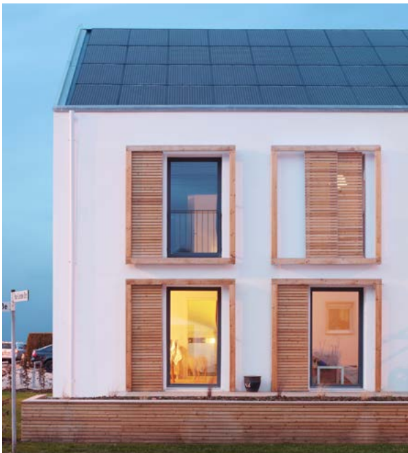
Effizienzhaus Plus Pfuher Straße 12-14, Neu-Ulm mit dachintegrierter Photovoltaikanlage
