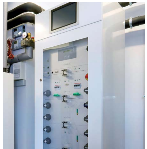
Batteriespeicher, 13,2 Kilowattstunden
