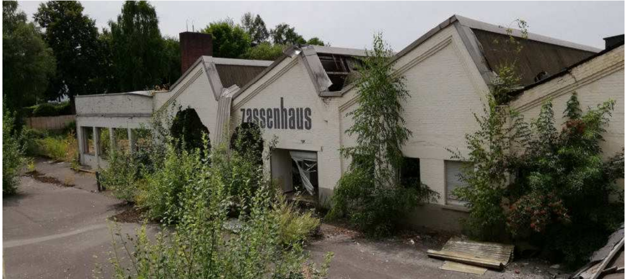
Abbildung 4: Baufeld Nord (Blick von Nordost, 01.08.2018)
