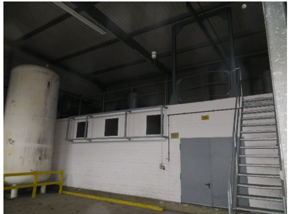
Innenbereich eines zugänglichen Gebäudes im Süden des Plangebiets
