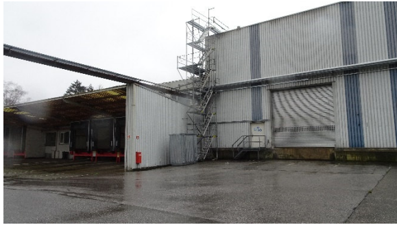
Gewerbehallen und Anlieferungstore (auf der linken Bildseite) im Nordwesten des Plangebiets
