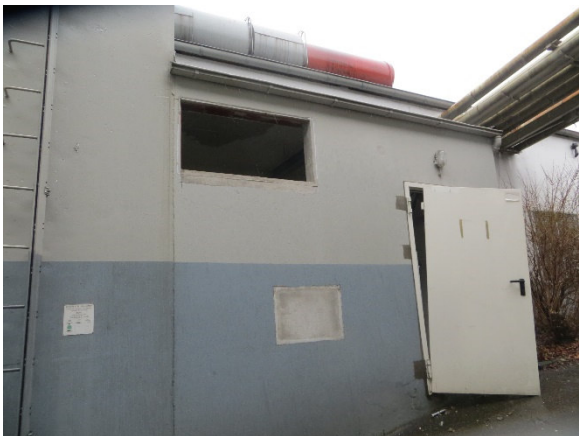
Nebengebäude mit offenem Fenster/Tür (Einflugmöglichkeiten für Fledermäuse/Vögel)
