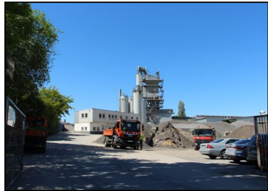
Abb. 4-10: Gelände des Mischwerks
