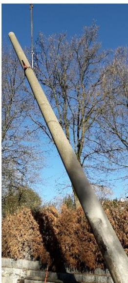
*Austausch defekter Betonmasten*
