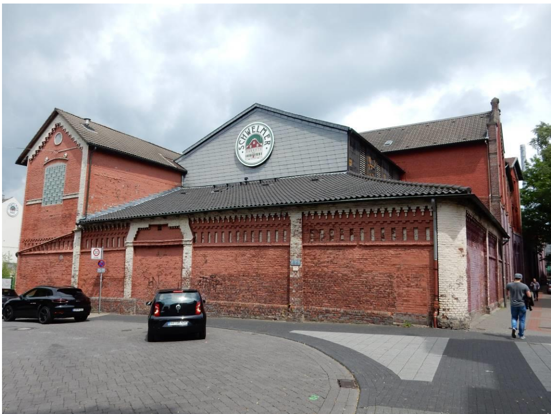
Schulstraße: Die Fassade an der Westseite der alten Brauerei.
