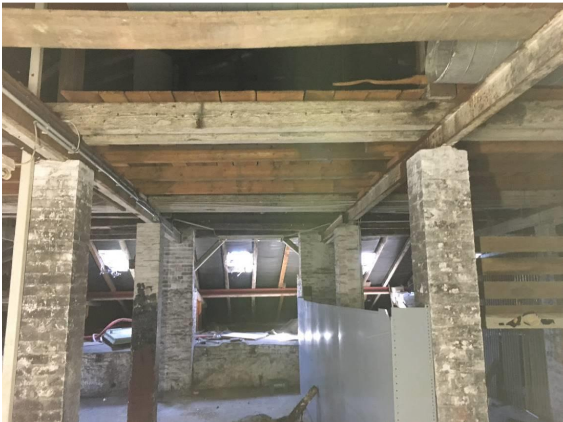
Dachboden des Hauptgebäudes
