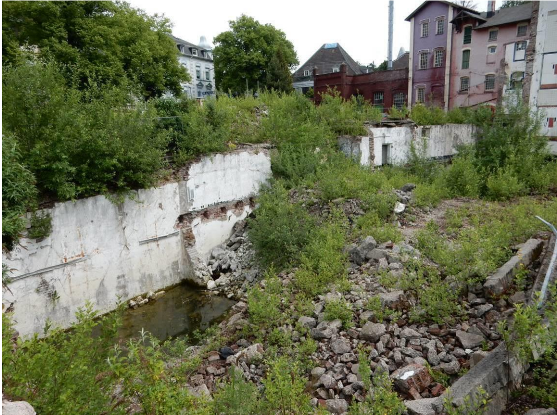
Bauschutthaufen und mit Regenwasser teilweise vollgelaufene, nach oben offene Kellerfundamente zeugen von den in 2012 erfolgten Abrissarbeiten auf dem ehemaligen Brauereigelände und lassen die bauliche Dimension der ehemaligen Brauerei erahnen.
