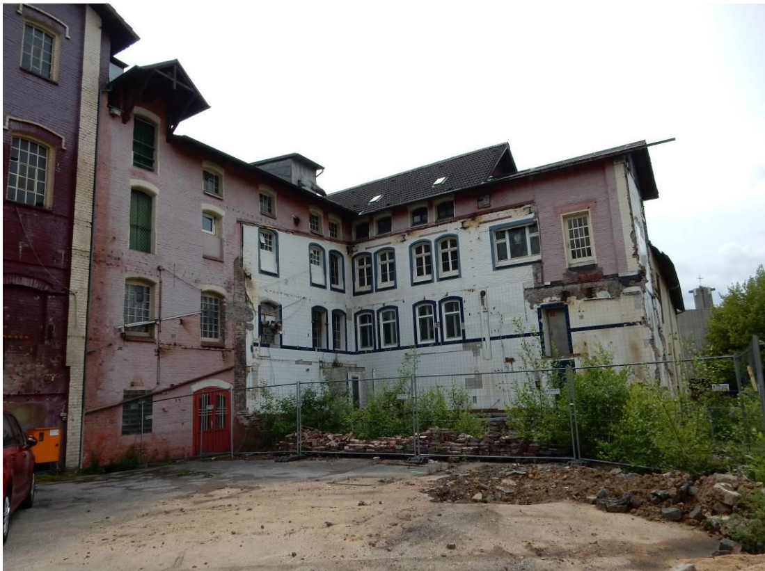
Teile der ehemaligen Gebäudekulisse sind bereits abgerissen worden.
