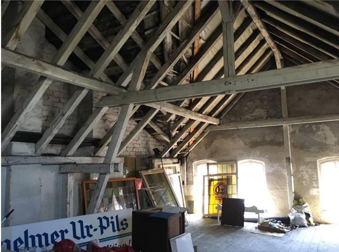
Die Dachräume des Hauptgebäudes sind trocken aber nicht wärmedämmend und für potenzielle Gebäudebesiedler von außen teilweise durch defekte Fenster zugänglich.
