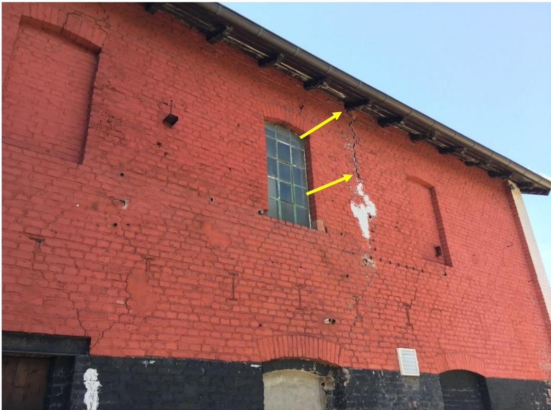
**Beispiel:** Im Ziegelmauerwerk der Außenfassade finden sich Risse, die teilweise bis zum Dachanschluss hinaufreichen und ggf. geeignete Spaltenquartiere für Zwergfledermäuse darstellen. Eine Sanierung der Mauerspalte (im unteren Bereich offensichtlich schon einmal erfolgt) könnte hier unerkannt zum „Einmauern“ von Tieren und in diesem Fall zu Tierverlusten und Verbotstatbeständen i.S.d. der § 44 Abs. 1 Nr. 1 BNatSchG führen.
