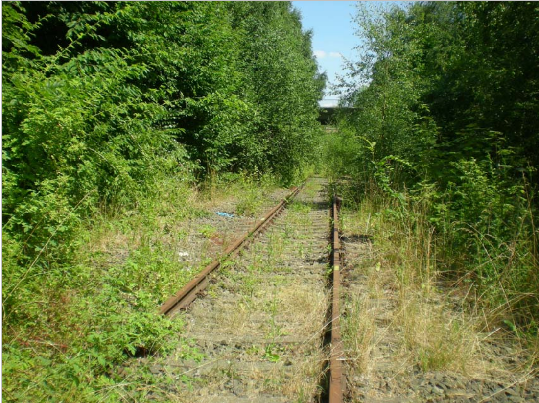
Im östlichen Plangebiet finden sich dichte Vorwaldstadien, die bereits randlich in die Gleisflächen einwachsen.
