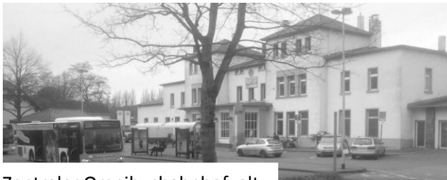
Zentraler Omnibusbahnhof, alt
