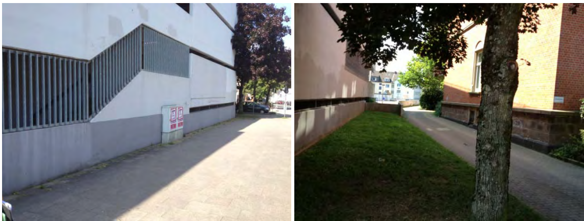
Abb. 38: Einfahrt Gerichtsstraße von Schulstraße (links), Blick in die Gerichtsstraße (rechts)
