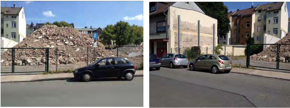
Abb. 4: Blick auf das Plangebiet von der Schulstraße aus
