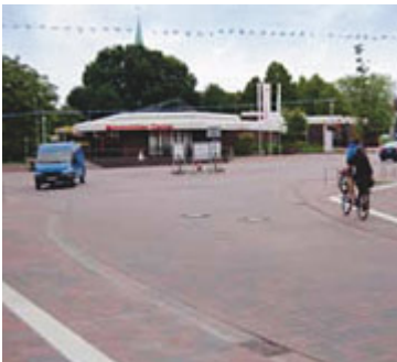
Die Kreuzung Richtung Westen vor dem Umbau und nachher. (Fotos > Stadt Bohmte)
